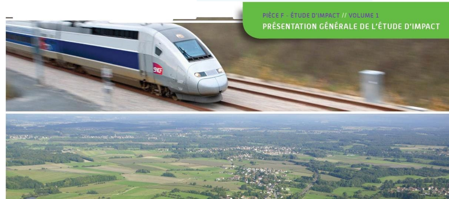
Ny højhastighedslinje Bordeaux-Toulouse, undersøgelse af klimavariationer og sårbarhed i infrastrukturen
